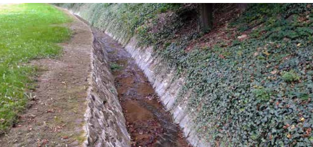
obrázek 4 – potok se zcela vybetonovaným korytem (zdroj: www.praha-priroda.cz)
