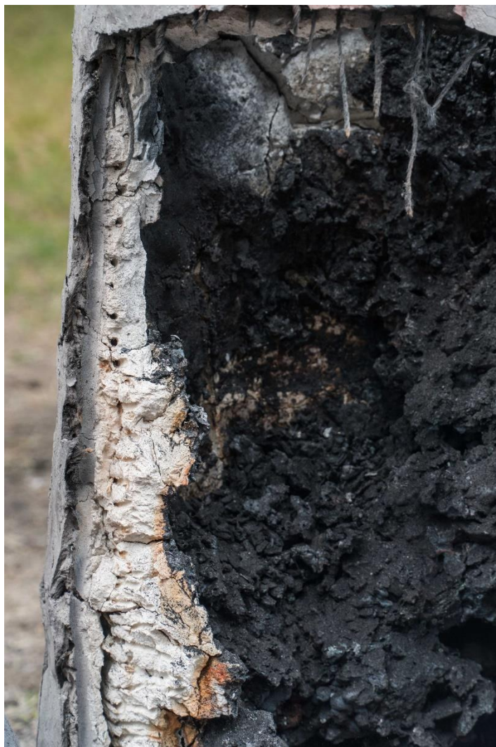
Obr. 5 Průřez stěny pece s dutinami po vypálené jutové tkanině, v horní části obrázku zuhelnatěla jutová vlákna. (Foto: Matouš Bičák)
