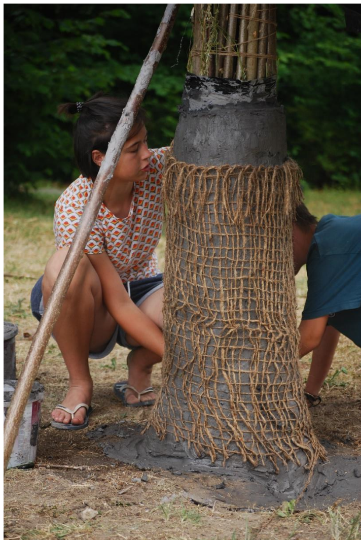
Obr. 3 Obalení první vrstvy jílu při stavbě komína pece e jutovou tkaninou. (Foto: Marek Matura)
