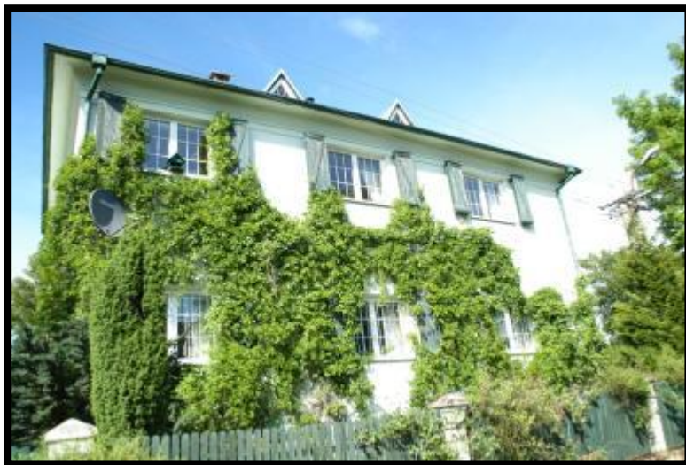
Budova školy, Dobrá Voda; Foto: Štěpán Řehák
