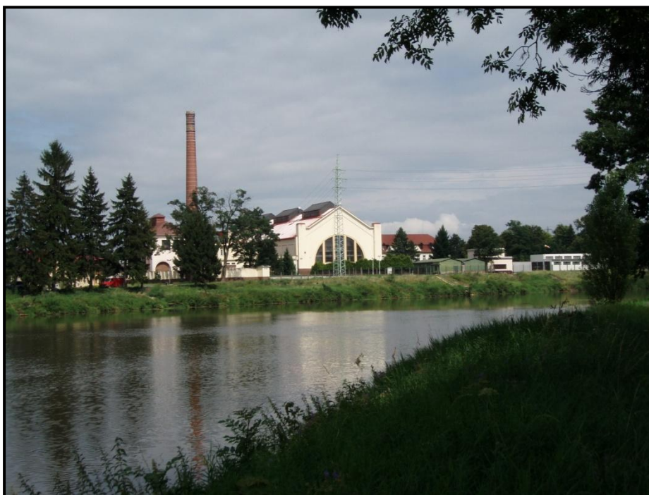
Obrázek č 3. Přečerpávací stanice v Káraném, dnešní stav (Filip Mašek)
