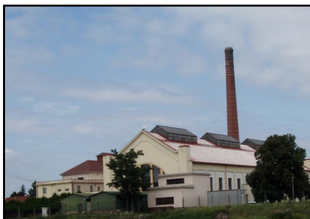
Obrázek č 18. Přečerpávací stanice, 2009 (Filip Mašek)
