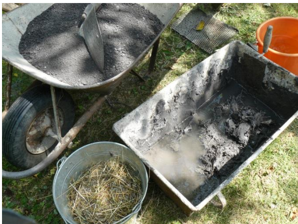
(Obr. 1) Jíl, vepřovice a namočené seno
