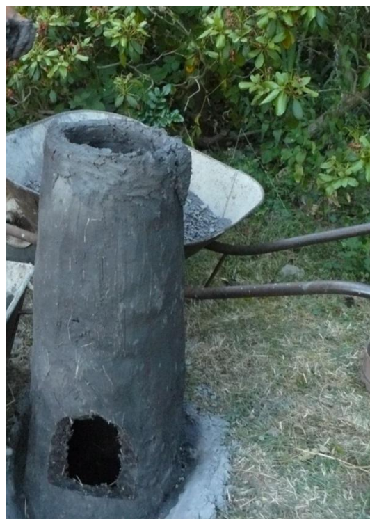
(Obr. 8) Postupné zamazání nerovností
