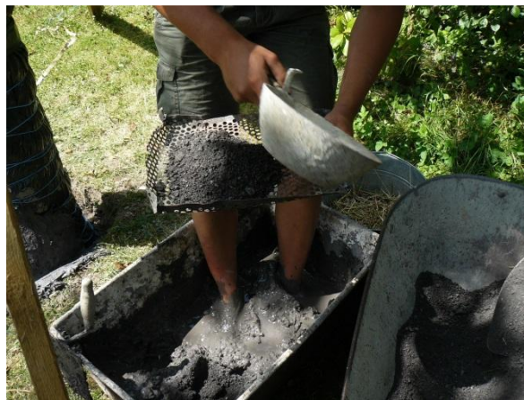
(Obr. 2) Šlapání vepřovice
