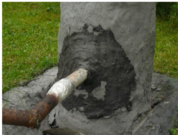
(Obr. 10) Zamazání dvířek s přívodem vzduchu
