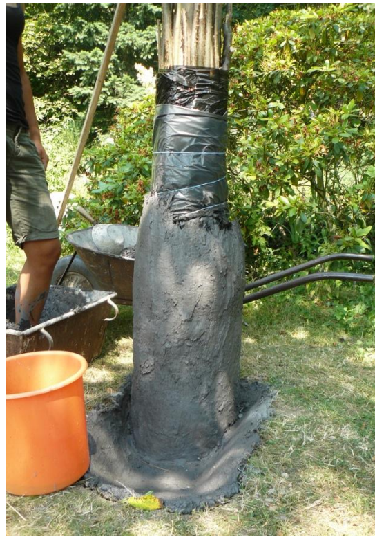
(Obr. 4) Stavba komínu pece
