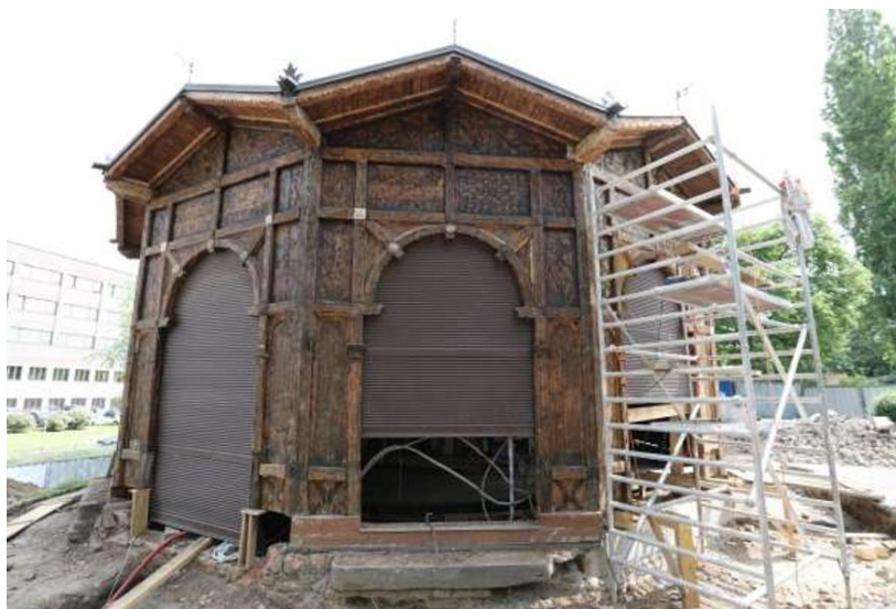
Obrázek 3 – Rekonstrukce pavilonu, NÁRODNÍ TECHNICKÉ MUZEUM, fotky z dokumentace rekonstrukce. Praha.
