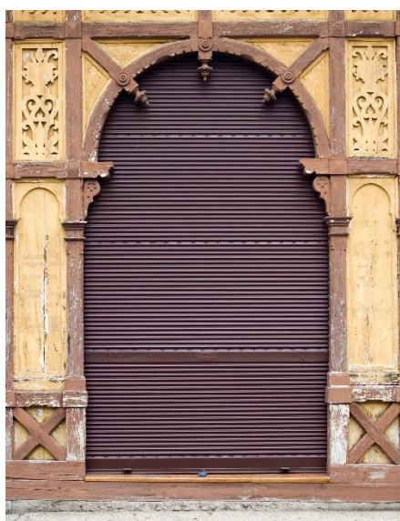
Obrázek 5 - Ukázka dřevěných trámů a kovových rolet, NÁRODNÍ TECHNICKÉ MUZEUM, fotky z dokumentace rekonstrukce. Praha.
