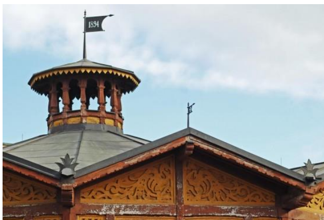
Obrázek 4 - Detail na lucernu, vyřezávané ornamenty a valbový typ střechy, NÁRODNÍ TECHNICKÉ MUZEUM, fotky z dokumentace rekonstrukce. Praha.
